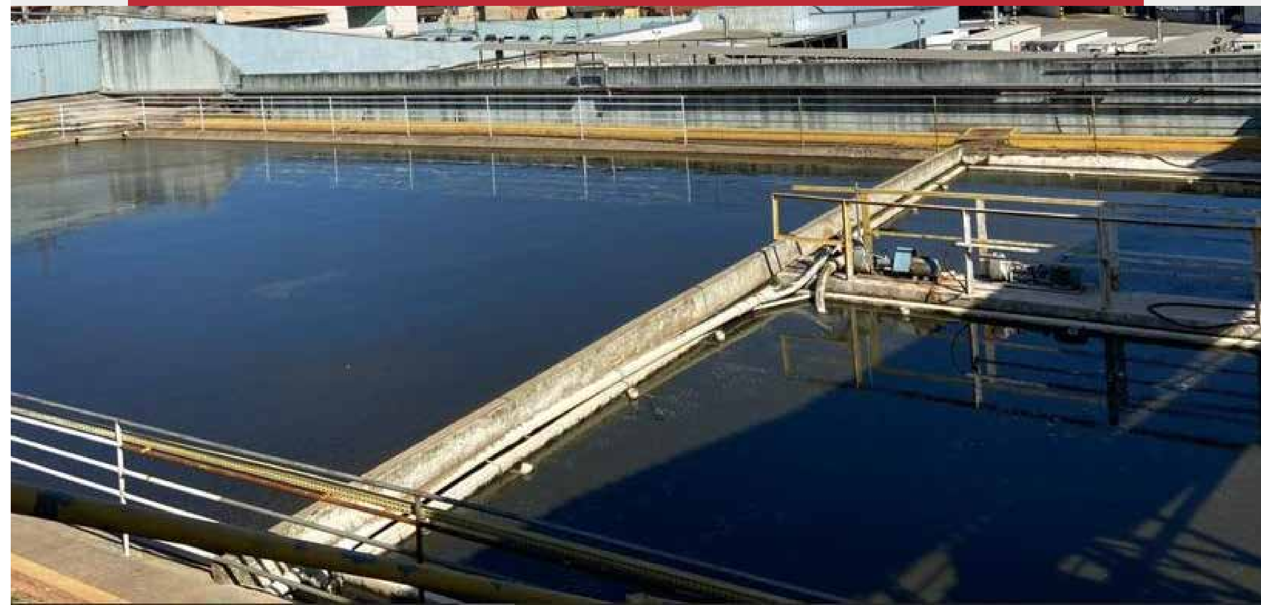
Estação de Tratamento de Efluente - Lagoa de Decantação
