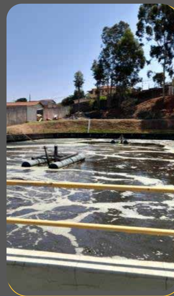
Estação de Tratamento de Efluente Biológico
